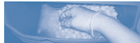
Abb. 7 „Der Boden des Solebehälters sollte sichtbar sein“
